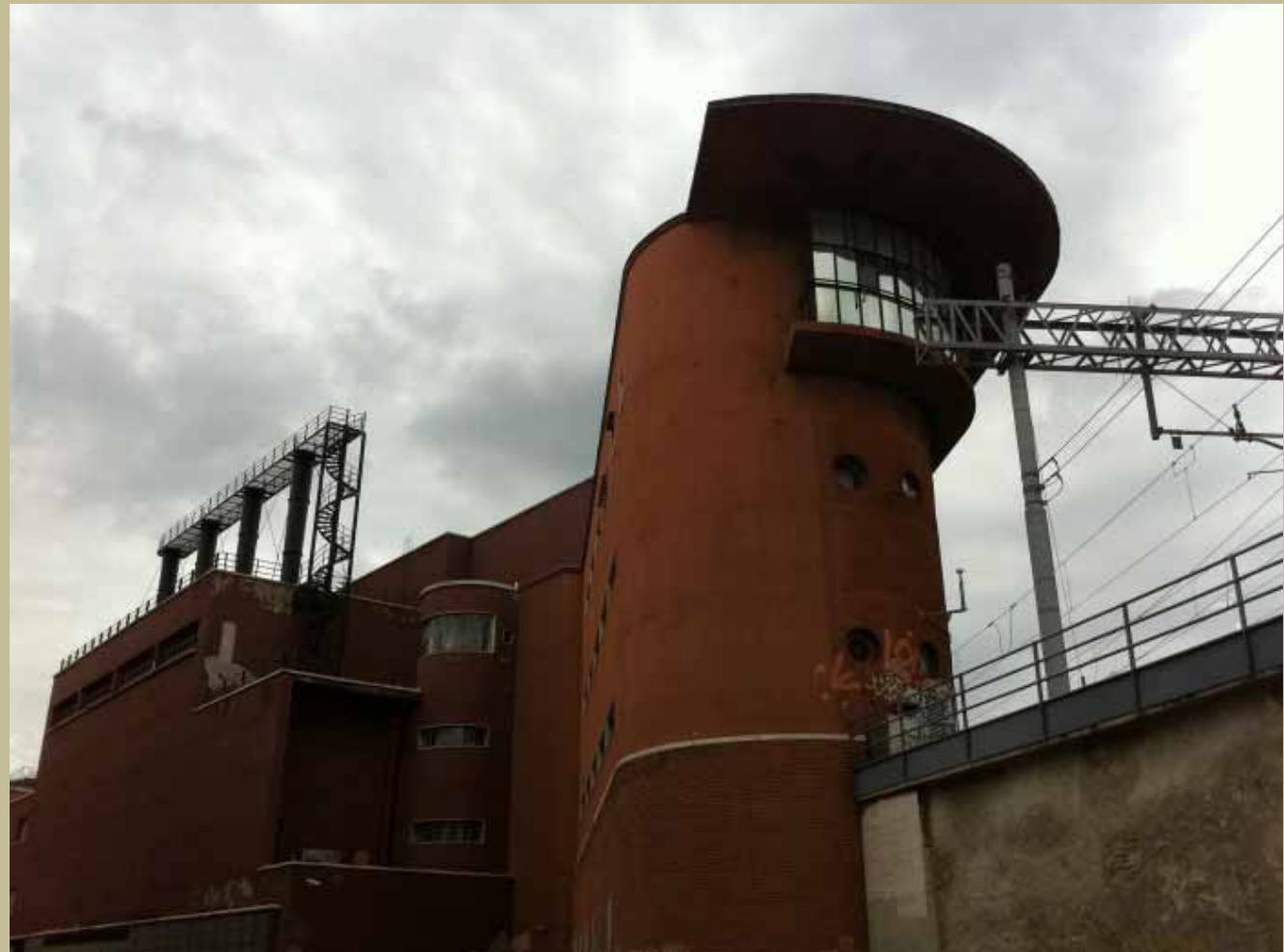
Firenze, ferrovia – 1934 Centrale termica e Cabina apparati centrali
